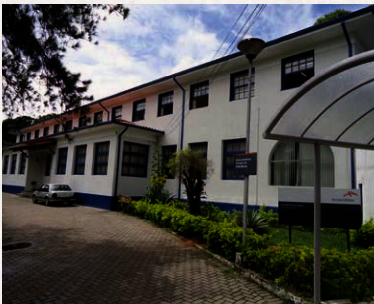
Fachada do Centro Clínico de Sabará, após a reforma.
